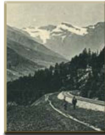
Costruzione della ferrovia del Brennero
